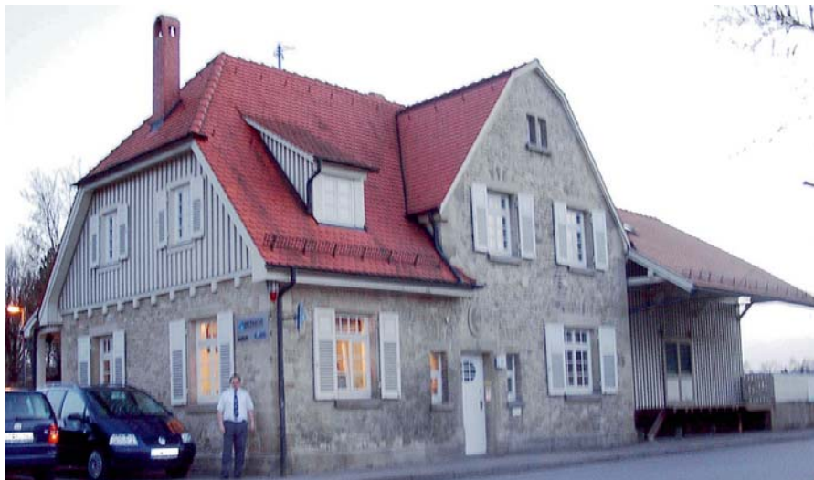
Firmenzentrale der Bethge Wassertechnik GmbH in Weil im Schönbuch: der denkmalgeschützte Bahnhof
